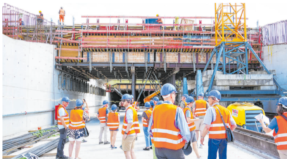
Ein Deckenelement wird hergestellt.
