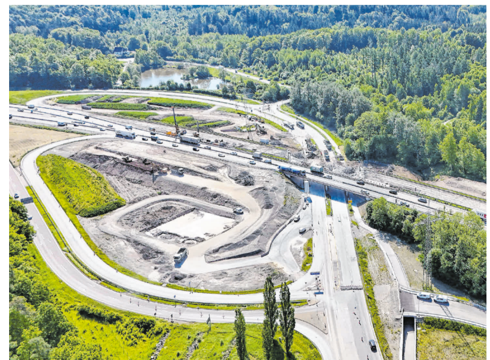
An der Anschlussstelle Sindelfingen-Ost wird auf der Seite, wo die südliche Brücke abgebrochen wurde, demnächst damit begonnen, die neue Betonfahrbahn zu bauen. Dafür muss die Auffahrt Richtung Stuttgart gesperrt werden, denn sie dockt an der Südseite an.
