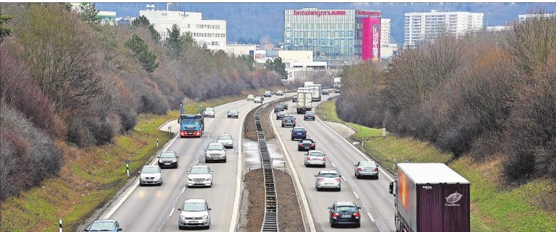
Das lange Warten hat ein Ende: Der Ausbau der A 81 zwischen den Anschlussstellen Sindelfingen-Ost und Böblingen-Hulb samt Überdeckung rückt in greifbare Nähe
