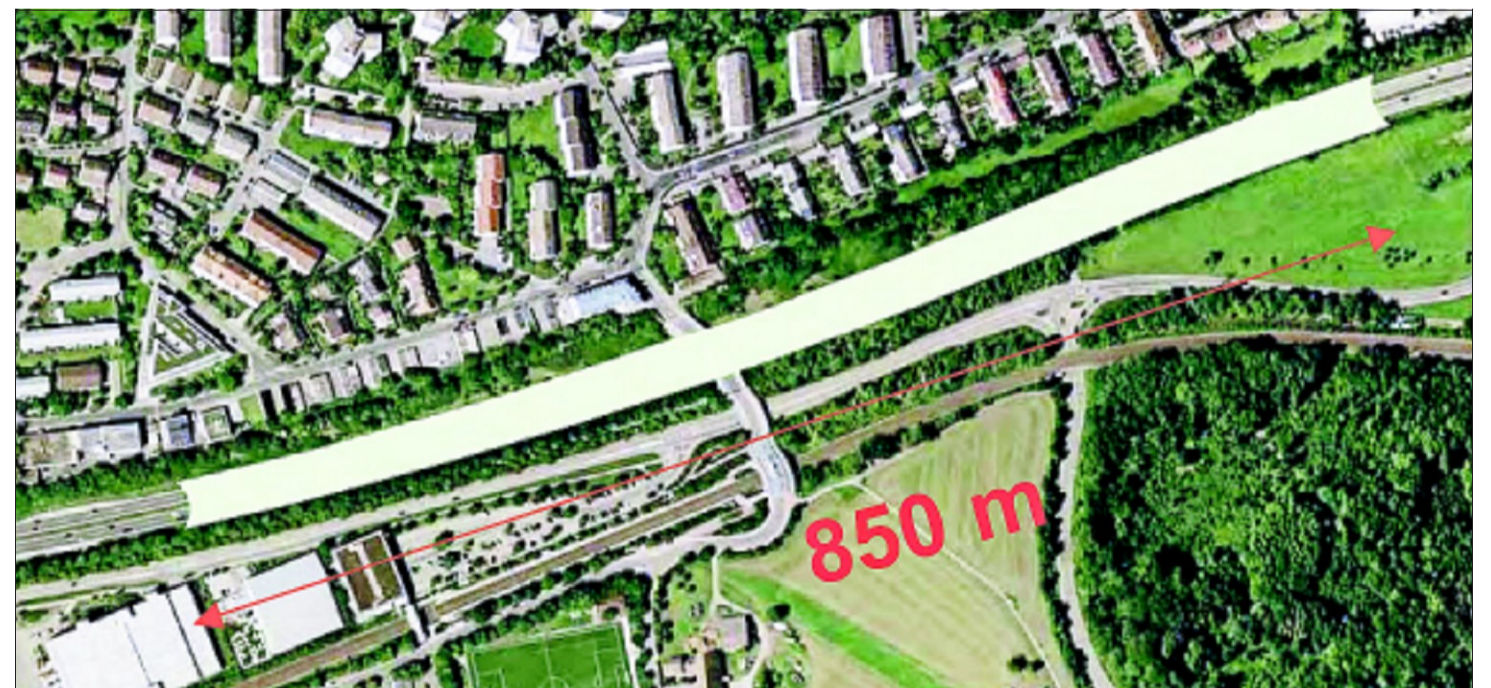
Es war ein langer Weg bis zu den Planungen eines 850 Meter langen Tunnels über der A 81 zwischen Böblingen und Sindelfingen
